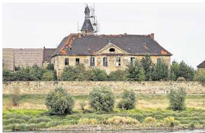
Der ganze Ort Promnitz samt Schloss stand während der Juniflut unter Wasser. Wie hoch die Schäden an dem Denkmal sind, ist noch unklar. Foto: Alex Schröter
